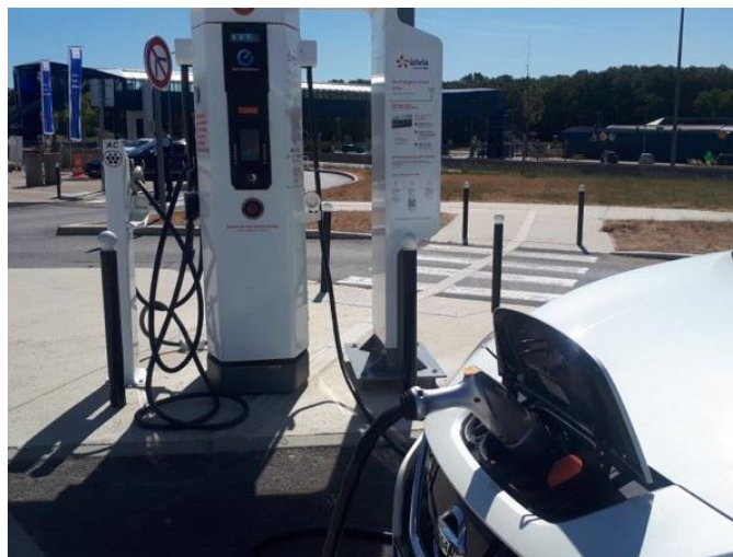
Charge rapide tri-standard DBT du réseau Corridor Aire de repos Chartres-Bois-Paris
